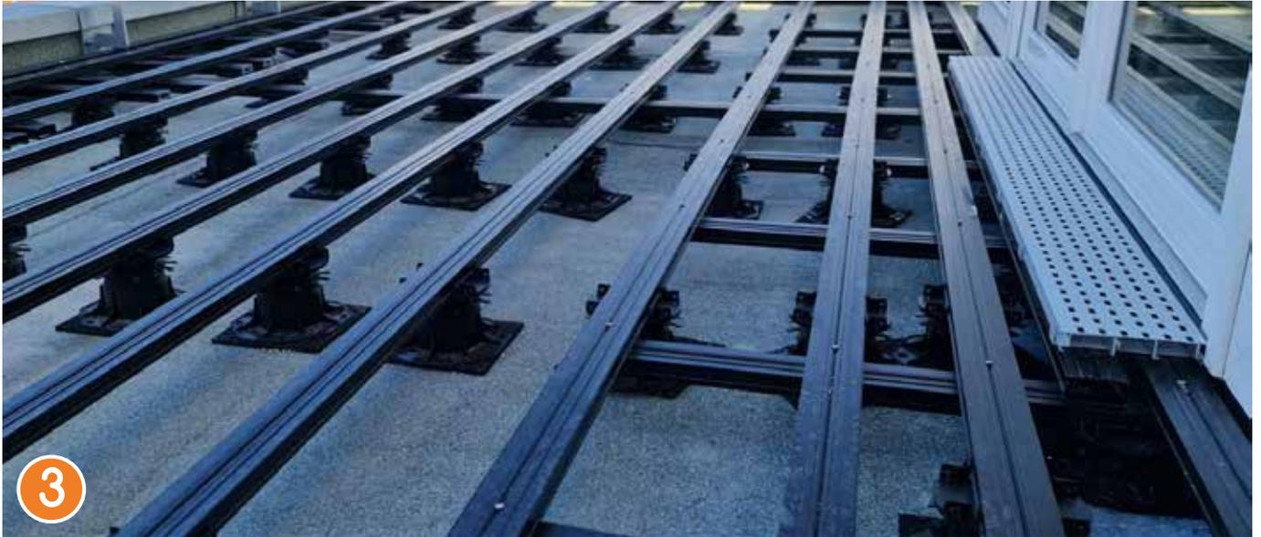
Dachterrasse/Laubengang auf Gefälledämmung mit Abdichtung
