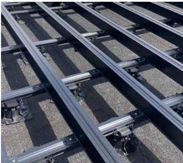
Unterkonstruktion mit Isostep-System
