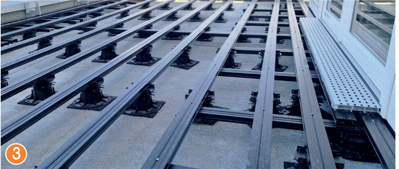
Dachterrasse/Laubengang auf Gefälledämmung mit Abdichtung
