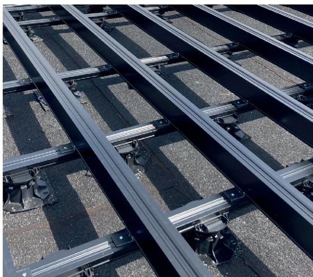
Unterkonstruktion mit Isostep-System
