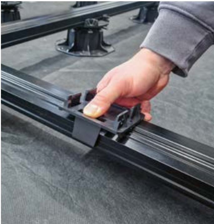
KL-Kreuzverbinder auf die ausgerichtete Konterlattung einklicken
