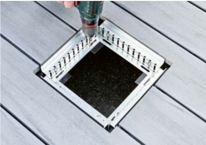
Revisionskasten einsetzen und an Windlastträger verschrauben.
