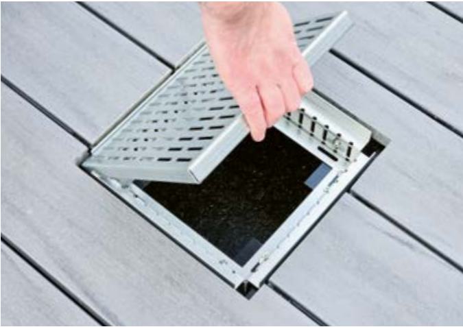
Abdeckblech in den montierten Kasten einlegen.
