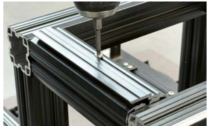
Z-Profil auf der Aluminium-Unterkonstruktion positionieren und befestigen.
