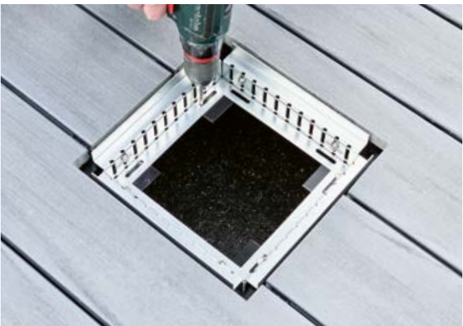
Revisionskasten einsetzen und an Windlastträger verschrauben.
