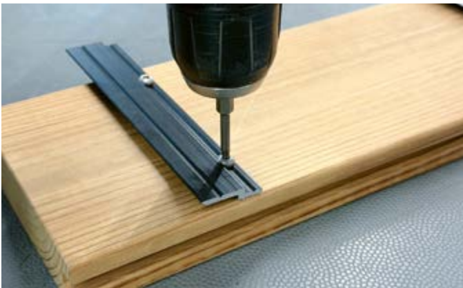
Z-Profil an der Deckbelag-Unterseite ausrichten und verschrauben.
