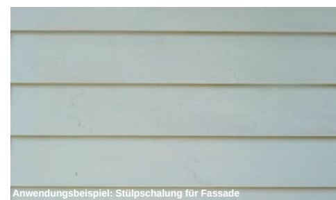
Anwendungsbeispiel: Stülpchalung für Fassade
